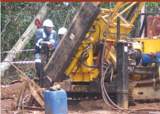
Drilling at Mebaga, Gabon
